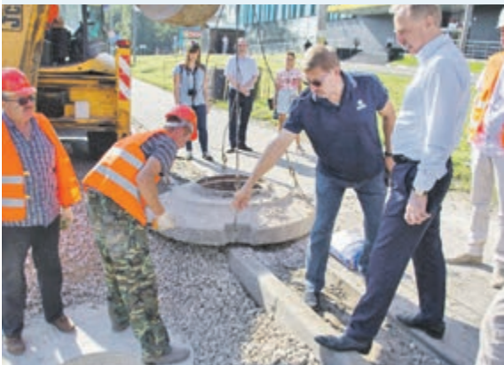
Глава Люберец Владимир Ружицкий проверил ход работ по строительству ливневой канализации.
