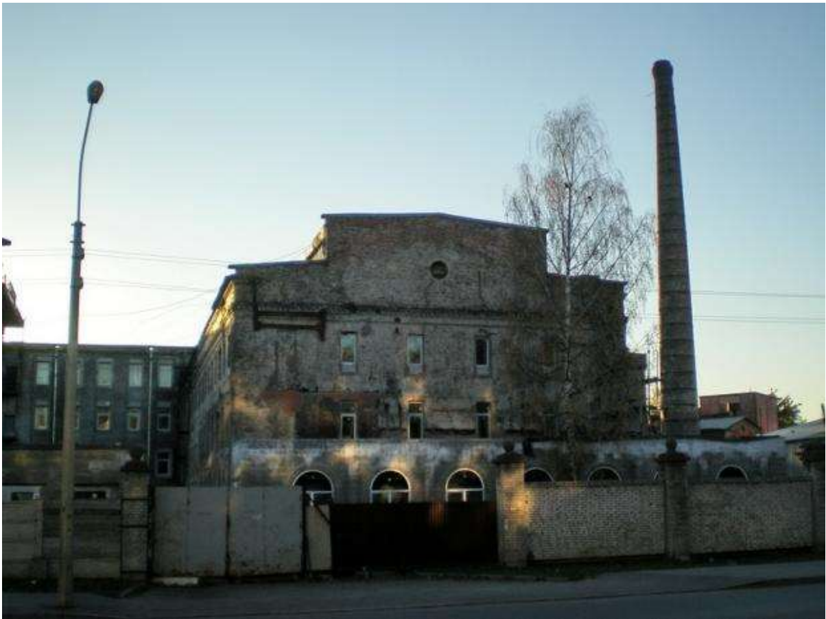
ОАО «Корниловский фарфоровый завод». Здание расположено по адресу: Полостровский пр. 59Б. Снято 06.10.2010.
