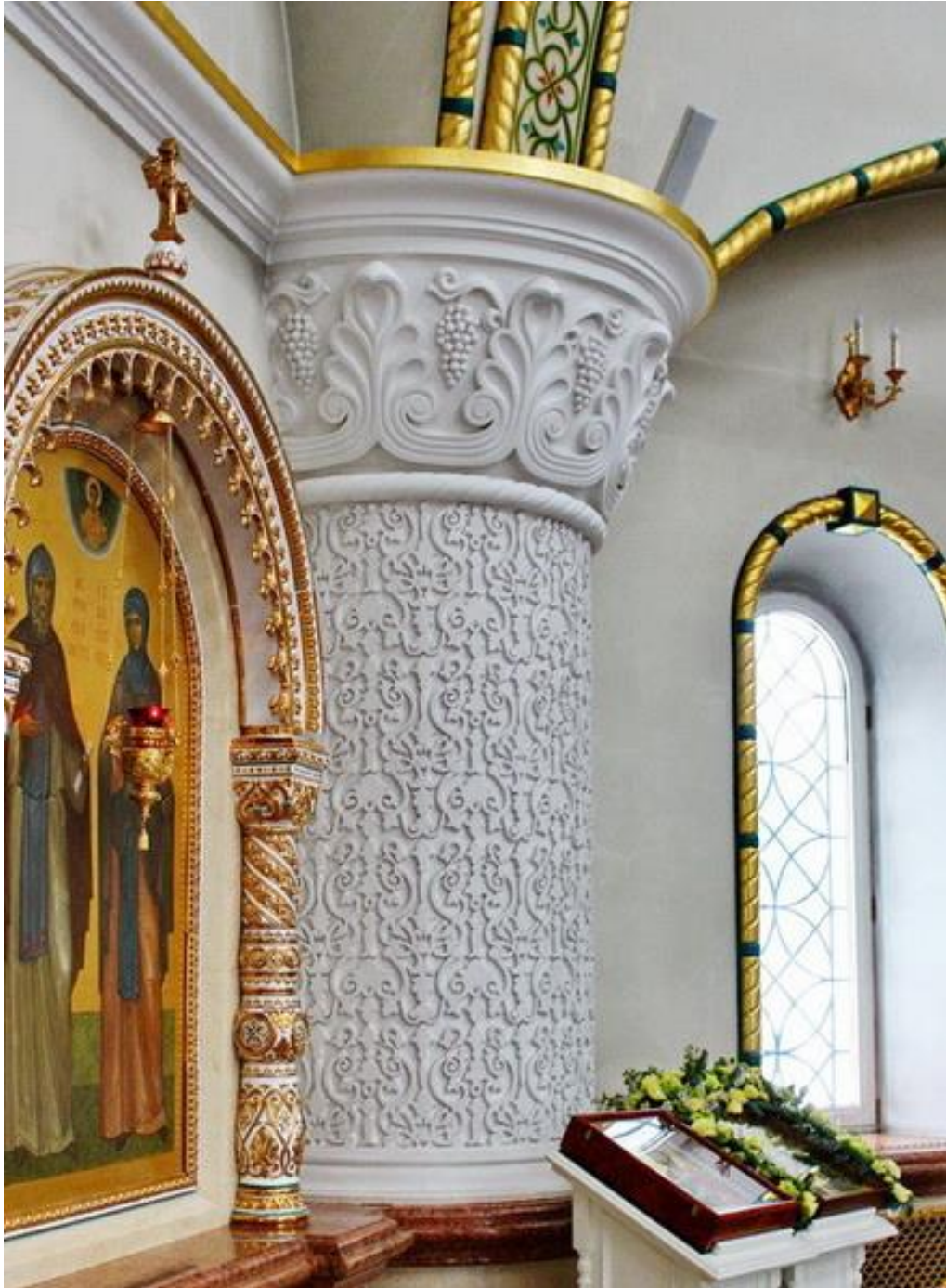
Колонна, поддерживающая своды собора Игоря Черниговского в Переделкино.
