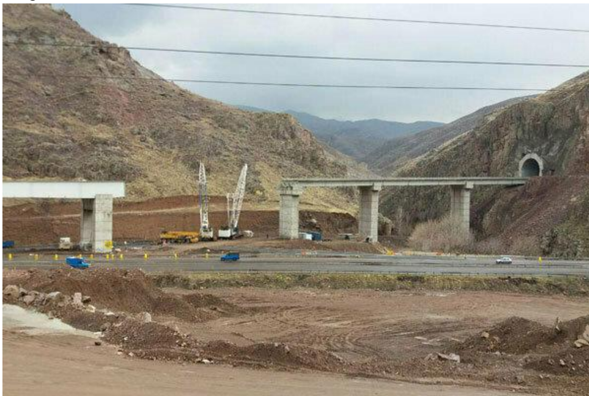
© mehrnews.com / CC BY 4.0 (Строительные работы на участке Казвин – Решт)
