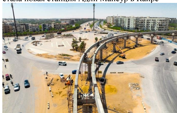
Строительство линии монорельса до Новой административной столицы (фото: NAT)
