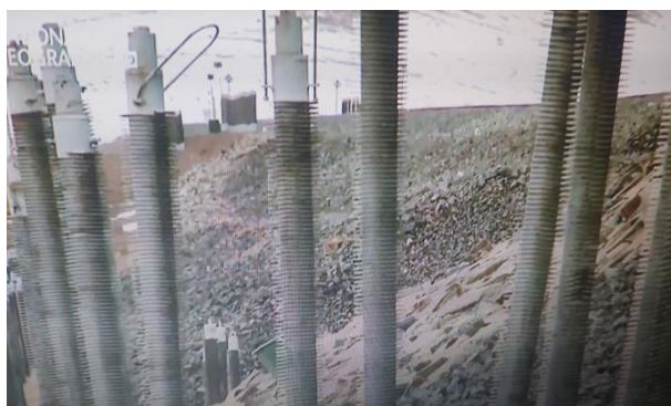
Термосифоны для охлаждения грунта
